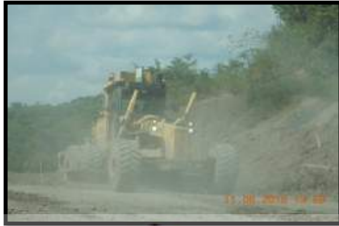
Gambar 4.13 Perbaikan Jalan Menggunakan Grader
